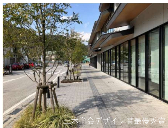
歩道隣接部に庇を設けた例 (佐伯市 さいき城山桜ホール)
