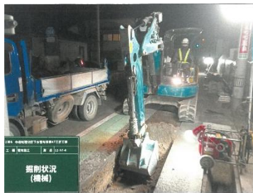
中府処理分区 下水道管布設状況
