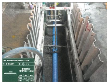
中府処理分区 下水道管布設状況
