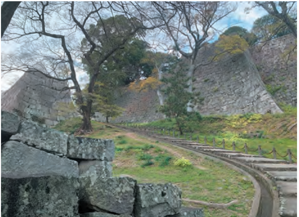
搦手筋の門跡及び三の丸石垣（南側）
