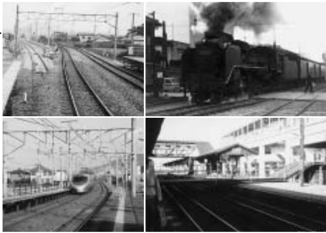
写真(右上):丸亀駅を発車する高松行きSL客車(昭和39年2月) (右下):旧線を橋で渡り、北側の高架新駅へ(昭和62年10月2日) (左上):讃岐塩屋駅の東で高架が替わる直前の様子(昭和62年9月) (左下):讃岐塩屋駅を通過する特急電車「しおかぜ」(平成20年1月)
