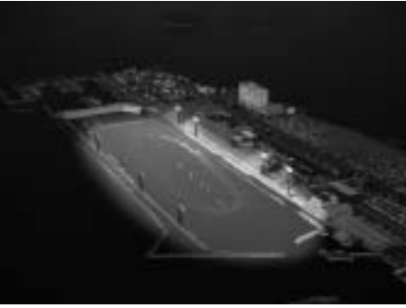
高さ40mの照明灯を8基設置。平成21年春からは、オールナイターレースでの営業を予定。
