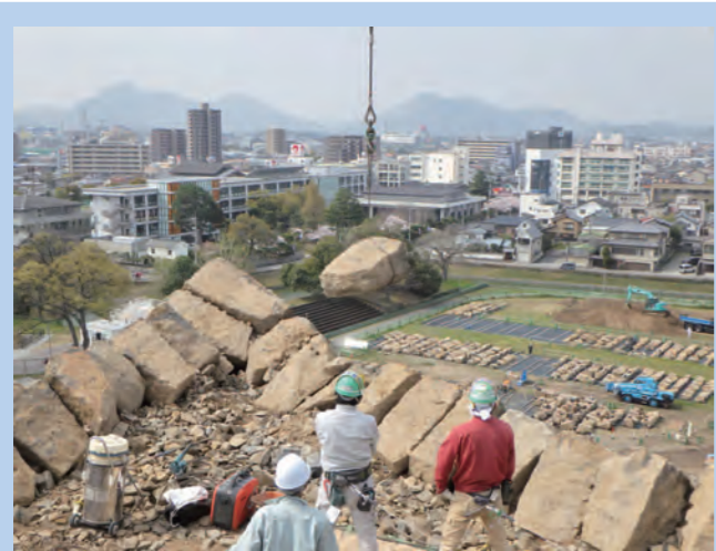
取り外した石材の運搬作業
