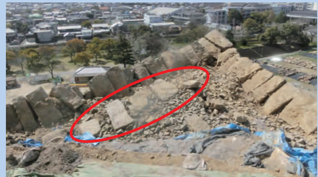
配列を保った状態で検出された礎石
