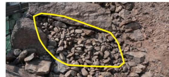
写真2 帯曲輪石垣断面写真
