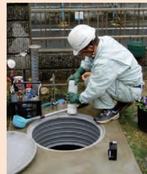
浄化槽は、微生物の働きで汚水を処理する装置であり、適切な維持管理をしないと生活污水がきちんと処理されず、地域の水環境に悪い影響が出ます。維持管理には保守点検・清掃・法定検査の3つがあります。
