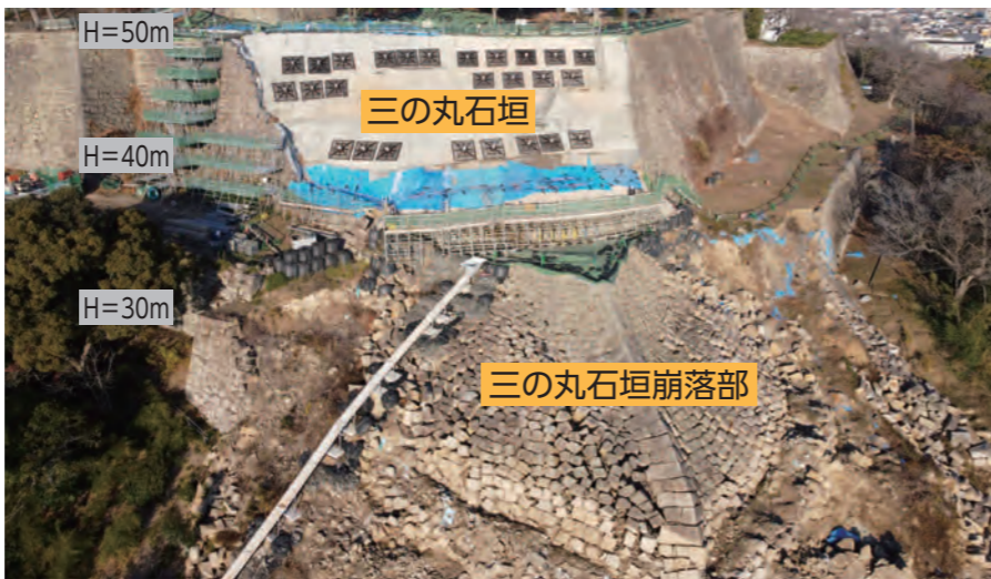
写真① 令和2年12月28日 石垣復旧工事現場
