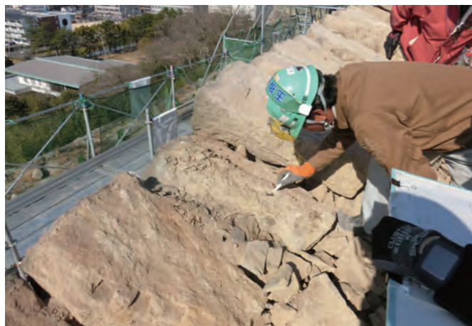
元通りに石垣を復旧するために、上の石を取り外したあと、下の石と接していた部分の確認をしている様子(2月中旬)
