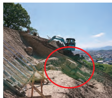
写真2 江戸時代に崩落したと考えられる三の丸坤櫓跡北東隅角部の石垣
