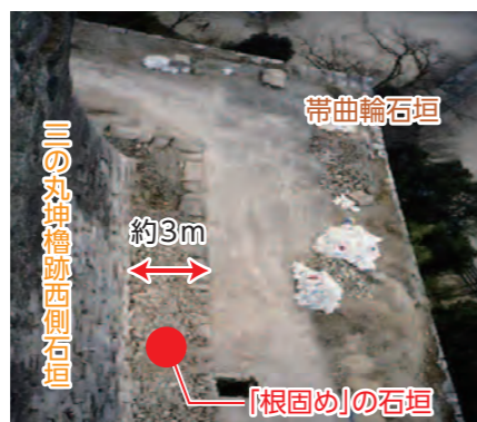
写真1 三の丸坤櫓跡西側基部
