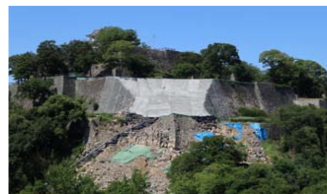
応急対策工事の完了
