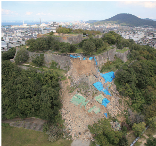
崩落した石垣の全景(10月9日撮影)
