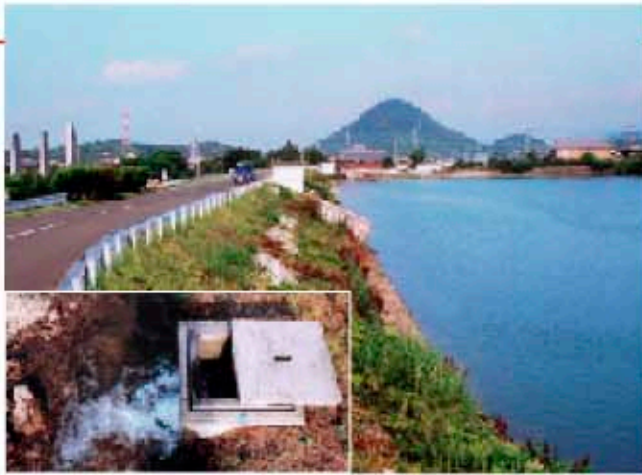
堤防上に改修記念碑の見られる仁池。正面は堤山(羽床富士) 大窪谷では、バルブを回すと容易に水が田に入る：写真左下
