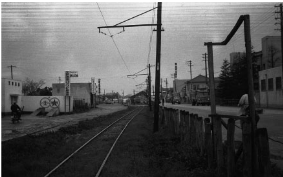
県道33号線大手町付近
