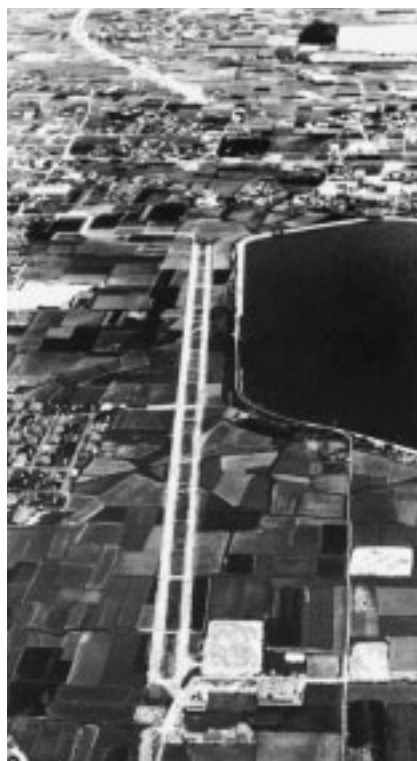
国道11号バイパス建設工事 (昭和50年ごろ)
