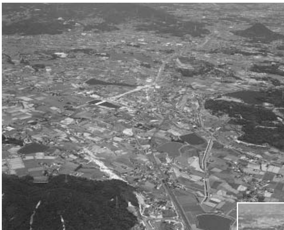
バイパス整備が進む国道32号
