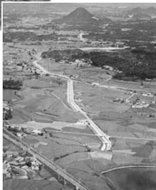
完成直後(昭和49年)の香川用水(奥は堤山)
