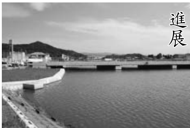
建設中の国道32号バイパス
