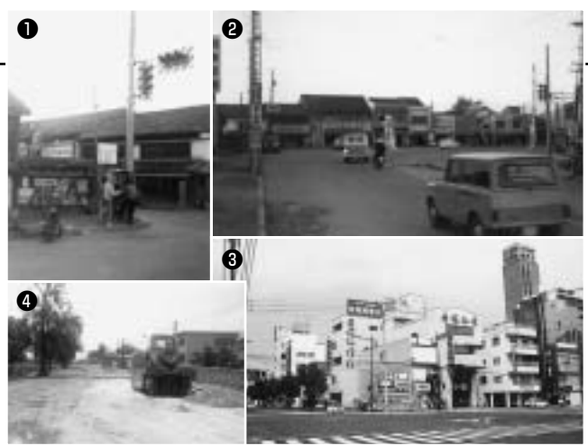
写真①②：昭和38年10月、市内初の道路信号機を設置中 ③：大きく変化した現在の塩飽町交差点 ④：昭和38年5月、丸亀城前県道の舗装工事
