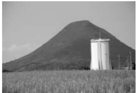
遠田配水池(飯山町)
