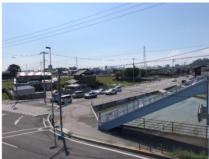
【市道西土器南北線の整備】
