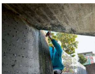
図 3.3 錆止めの塗布
