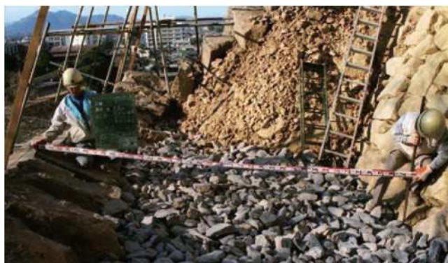
（a）修復工事で確認された栗石層
