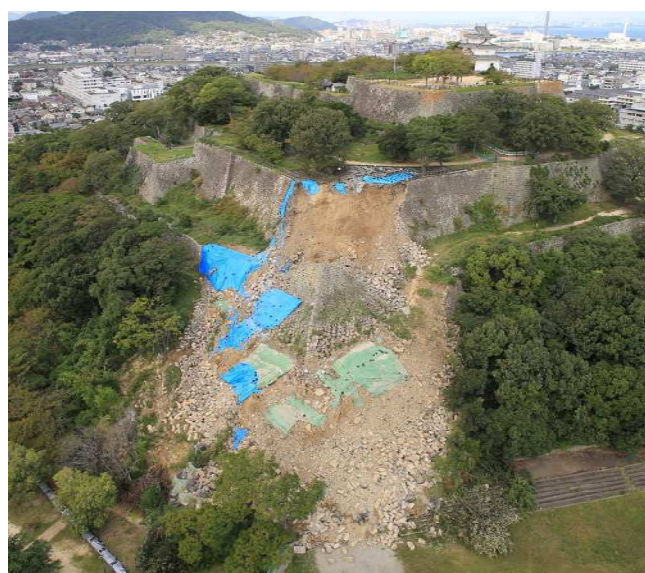
(c) 三の丸坤櫓櫓跡の崩落状況
