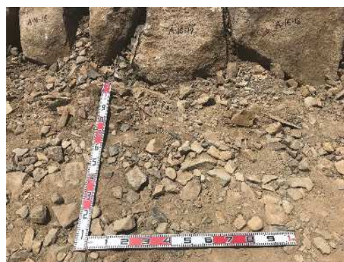
図 2-12 EL+42.5m の石垣背面栗石の拡大写真
