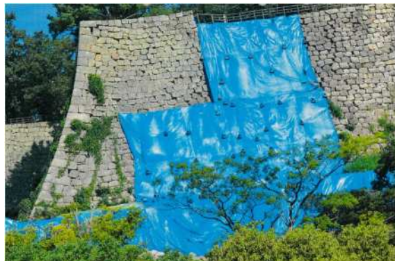
（b）三の丸天端の表流水の導水状況
