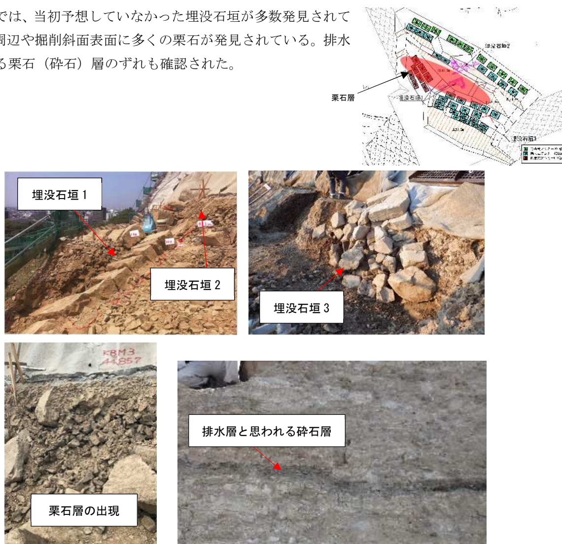
図 2-11 掘削工事中に発見した埋没石垣と栗石層
