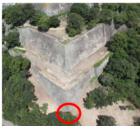
(a) 排水遺構検出箇所 (南西角部)
