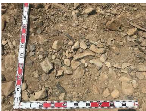
図 2-12 EL+42.5m の石垣背面栗石の拡大写真
