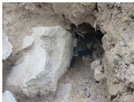
(c) 排水遺構 (栗石による排水路)
