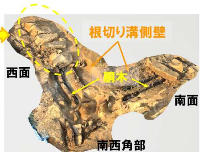
図 2-17 三の丸石垣の根石付近の状況
