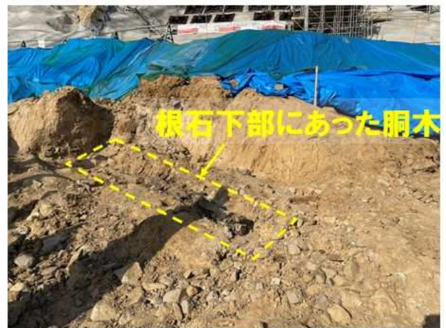
図 2-16 帯曲輪石垣の根石付近の状況
