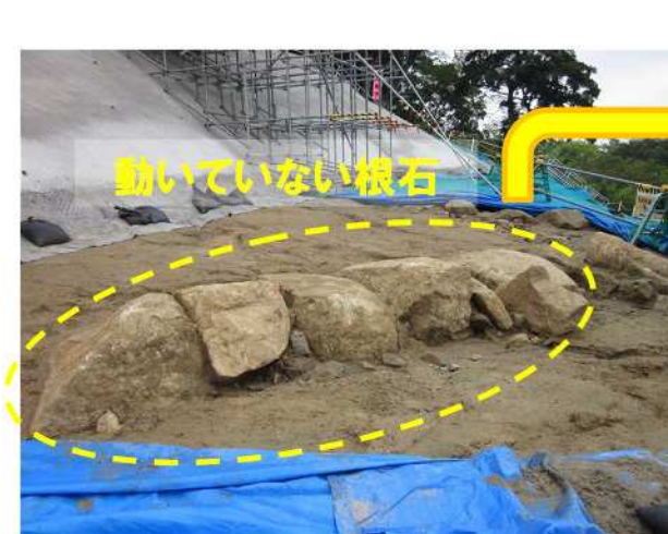
図 2-17 三の丸石垣の根石付近の状況
