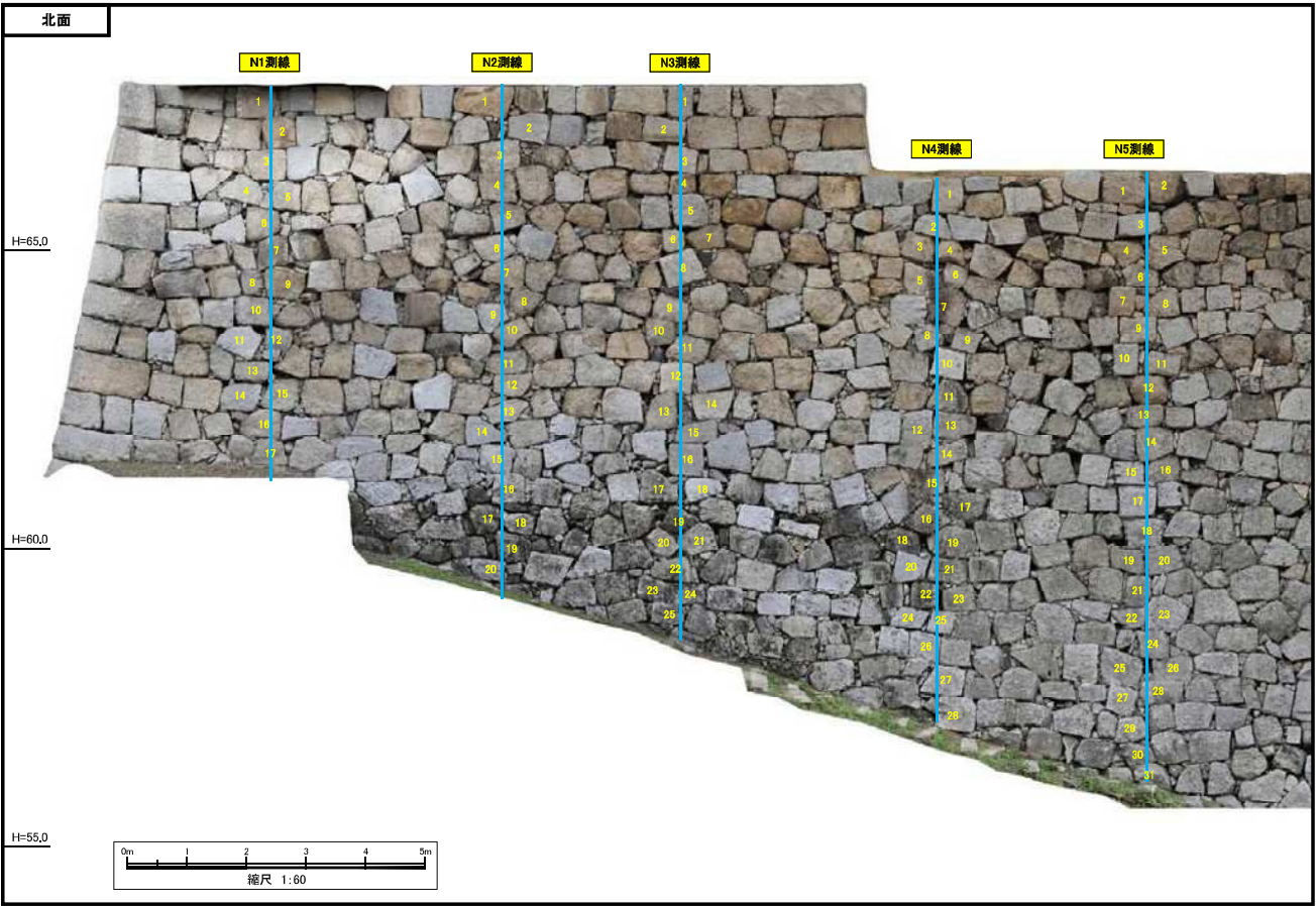
参考図 石垣控え長測定の測定位置（北面）
