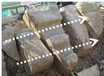
【D面38段目・胴木設置用に加工された石】
