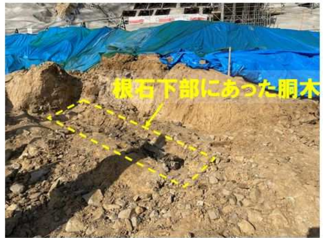
図 2-16 帯曲輪石垣の根石付近の状況
