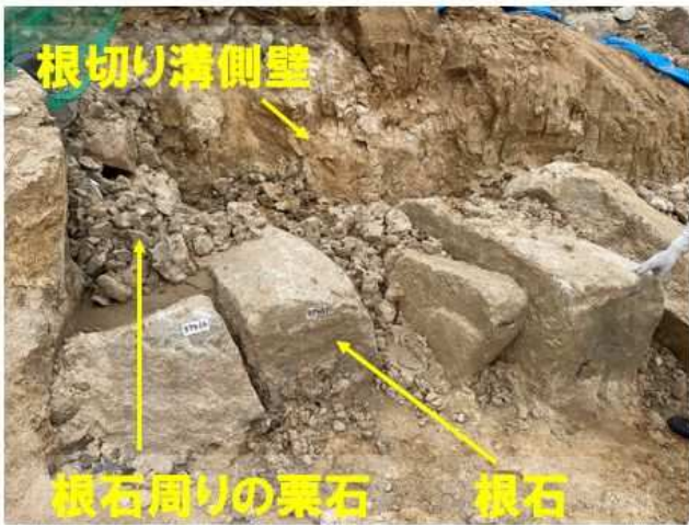
図 2-16 帯曲輪石垣の根石付近の状況
