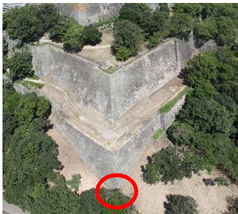
(a) 排水遺構検出箇所 (南西角部)
