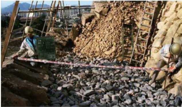
(a) 修復工事で確認された栗石層
