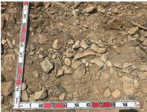
図 2-12 EL+42.5m の石垣背面栗石の拡大写真
