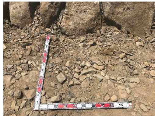
図 2-12 EL+42.5m の石垣背面栗石の拡大写真
