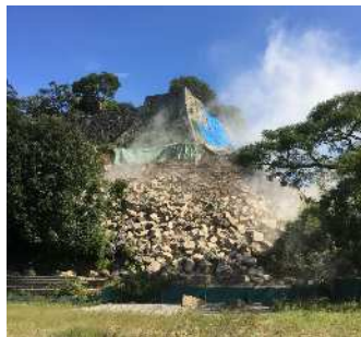
② 帯曲輪南西角部の崩落
