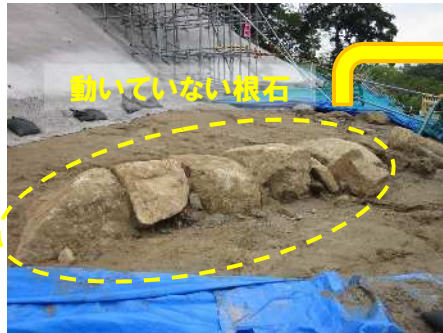
三の丸石垣の根石出現状況 (西側から東側に向かって撮影)
