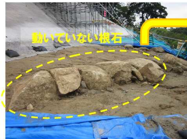
図 2-17 三の丸石垣の根石付近の状況
