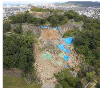
③ 三の丸坤櫓跡の崩落
