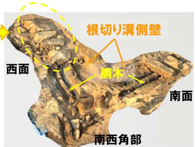
図 2-17 三の丸石垣の根石付近の状況
