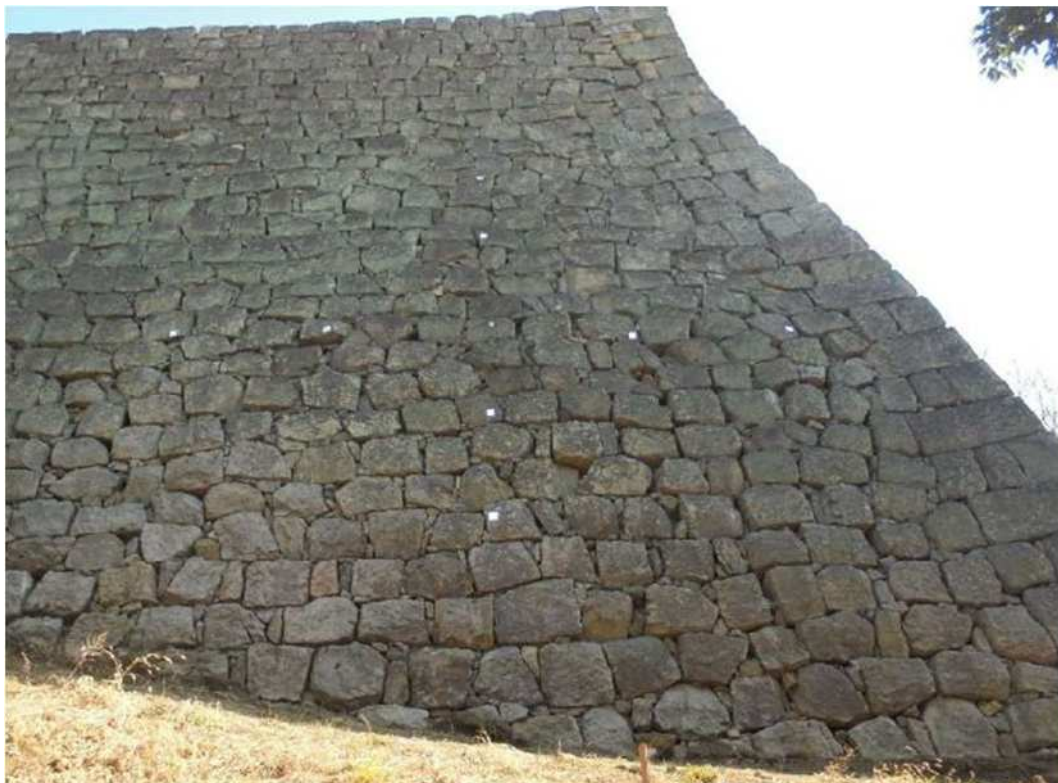
図 2-23 帯曲輪石垣の変位量の測点設置状況
