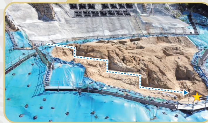
帯曲輪石垣基底部の段切り（……水の流れ）
