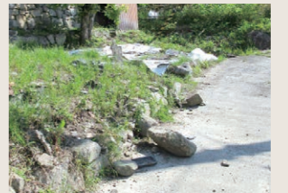
▲イノシシによる被害例 (住宅地の石垣が崩された様子)
