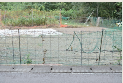
▲侵入防止柵(ワイヤーメッシュ柵)
