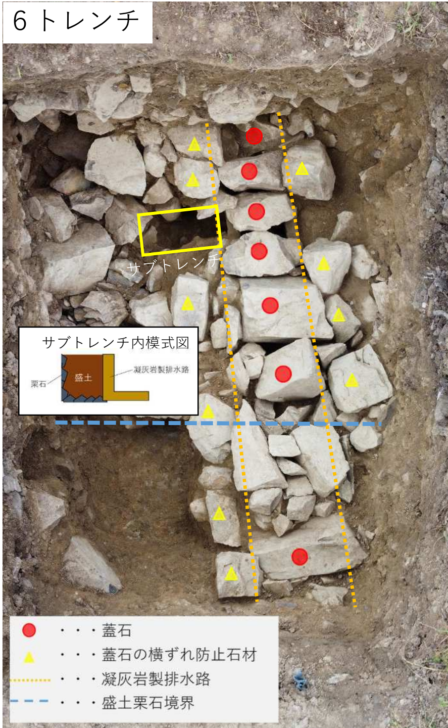
暗渠排水路施工工程模式図
