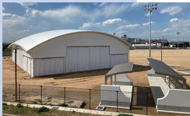
整備中の屋根付き広場と多目的広場
