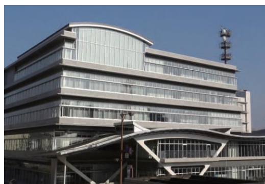
地中熱利用型空調システムを導入（市庁舎）
