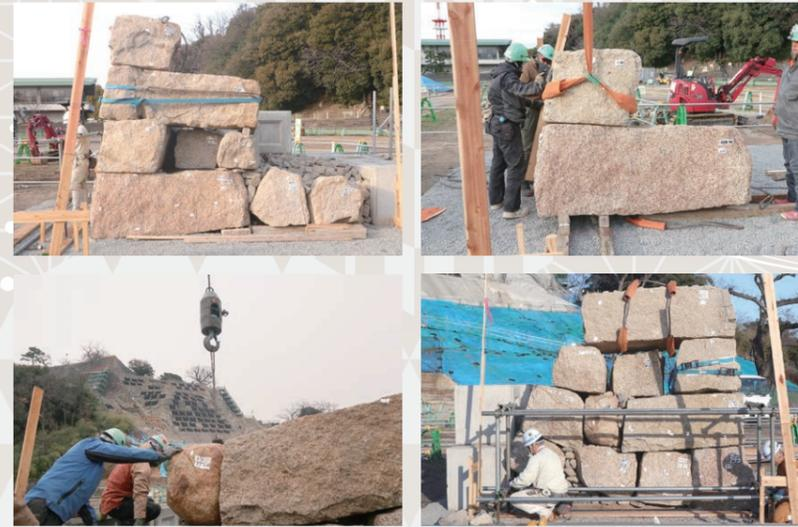
石垣積み上げ工事に向け、旧城内グラウンドの一角では帯曲輪石垣の試験積みが行われています。復旧する三の丸石垣と帯曲輪石垣は、積み始めの位置がともに地中部であるため、崩落前にどんな勾配でどのように積まれていたかを記録した測量図や写真がありません。そのため、崩落した石垣を回収するときに確認できた石の並びや段数をもとに、勾配や石の置き方を推測しながら積みなければなりません。試行錯誤を繰り返しながら、できるだけ本来の姿に近づけるよう取り組んでいきます。
