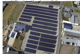
こんびらソーラー発電所
