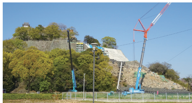
丸亀城石垣復旧工事
