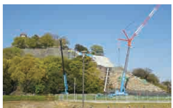
丸亀城石垣復旧工事
