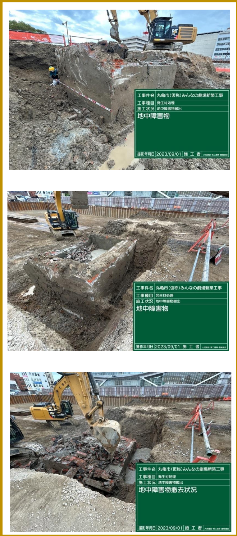
地中障害撤去状況
