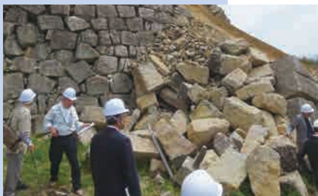
石垣崩落現場
