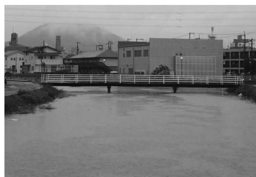
台風による大雨で増水した西汐入川
