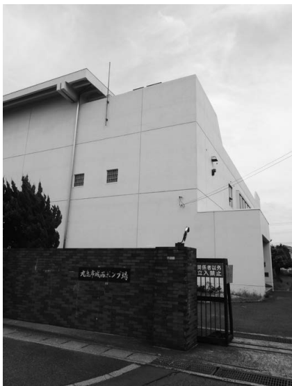
城西ポンプ場
