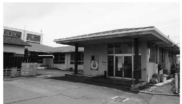
建て替え中の城坤コミュニティセンター
