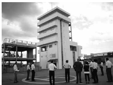
消防訓練棟を視察
