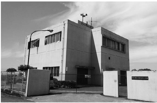
塩屋ポンプ場
