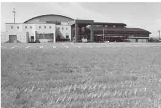
駐車場を拡張する飯山総合学習センター
