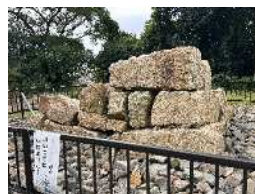
←三の丸石垣斜面で見つかった埋没石垣(石垣復旧PR館前に展示中)
