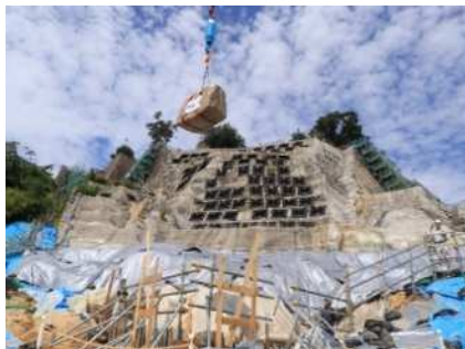
【クレーンによる根石の吊り上げ】
