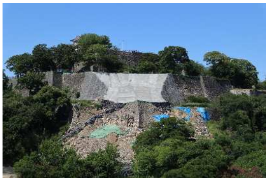
令和元年6月 応急対策工事完了時
