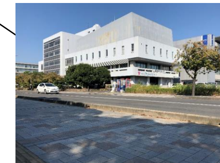
生涯学習センターは解体 予定である（機能は市民 会館などへ）
