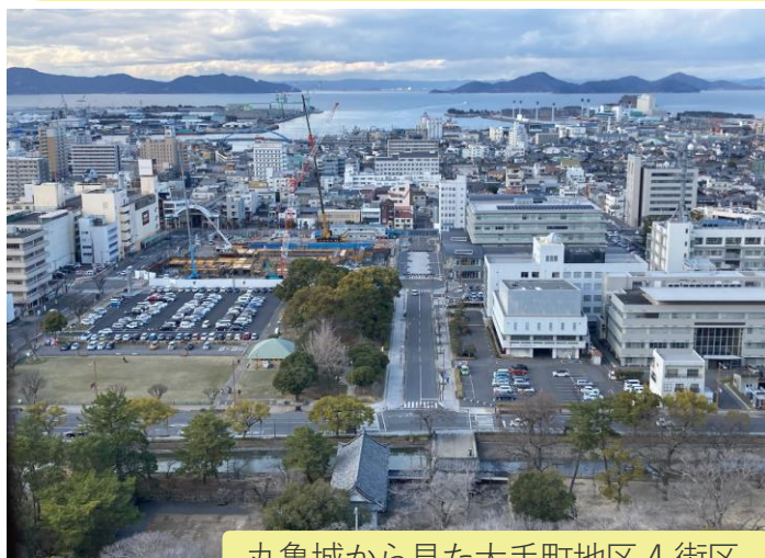
丸亀城から見た大手町地区4街区
