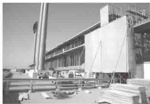
改築工事中の丸亀ボート場
