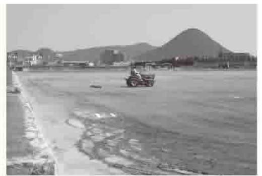
完成間近の総合運動公園多目的広場
