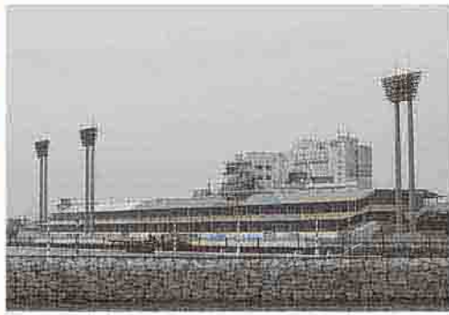
改築工事が始まる競艇場
