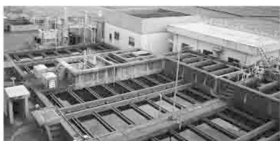
大切な水を供給します（垂水浄水場）
