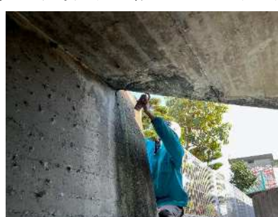
図 3.3 錆止めの塗布
