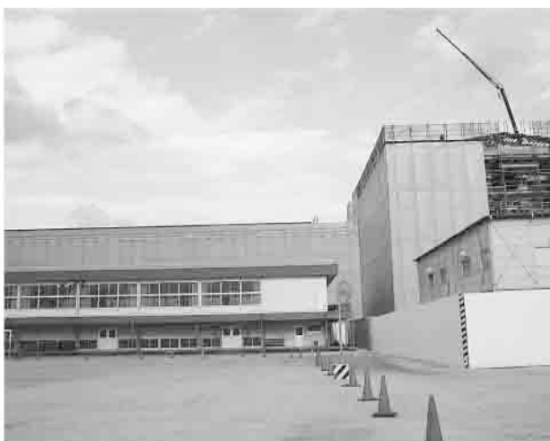
5月の完成を目指し改築工事が進む「西中学校」
