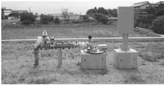
渴水に備え深井戸の整備を進めています
