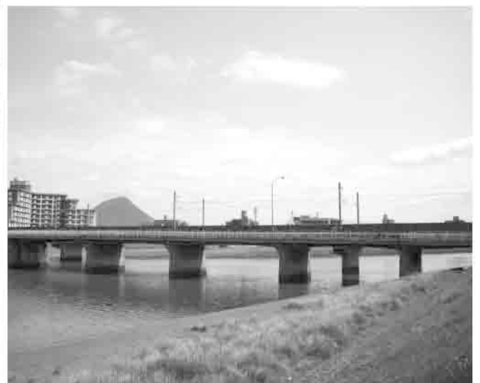
建設後50年以上経過している土器川橋
